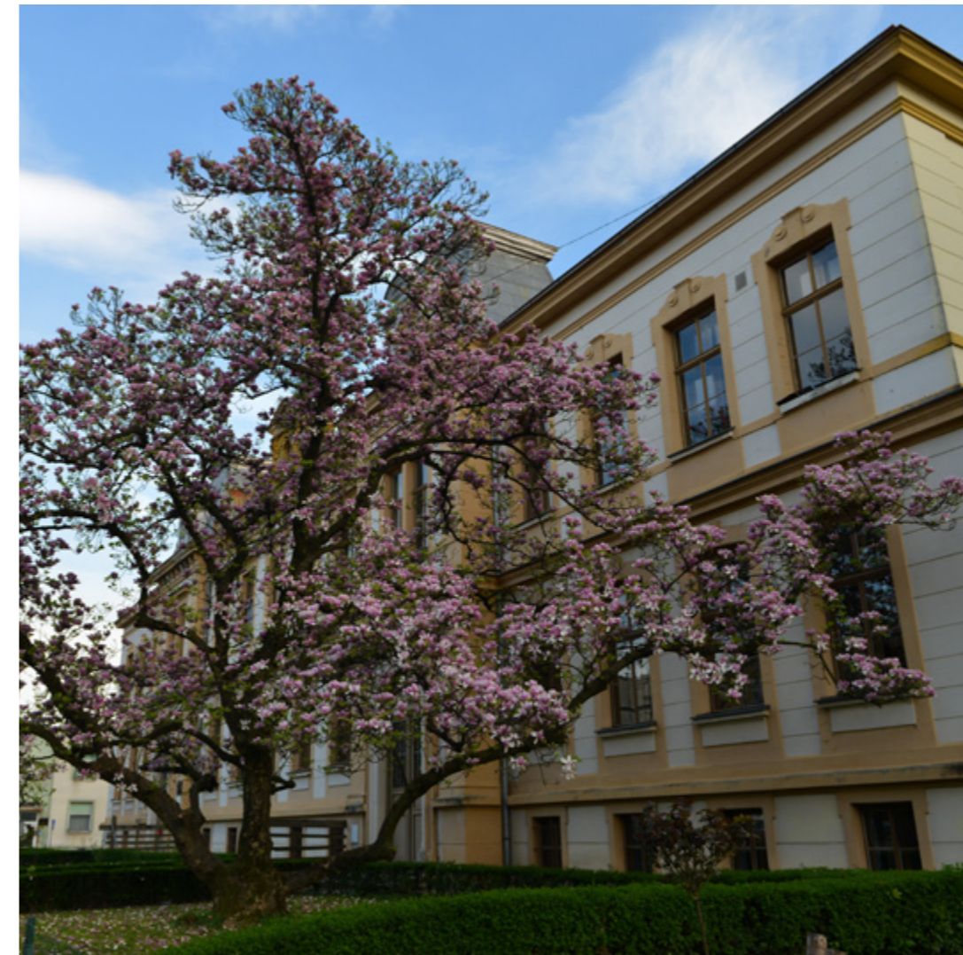
Pogled sa sjevero- zapada na zgradu Gimnazije
