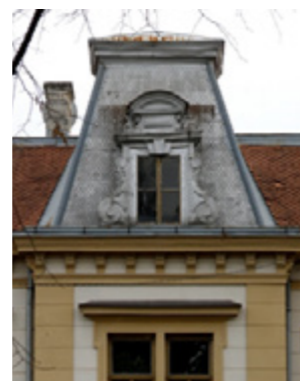
Detalj krovne kape na sjevernom pročelju Gimnazije, D.K.
