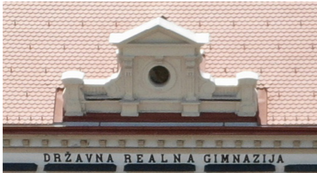
Detalj atike na sjevernom pročelju Gimnazije, D.K.
