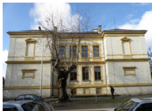
Istočno pročelje Gimnazije, D.K.
